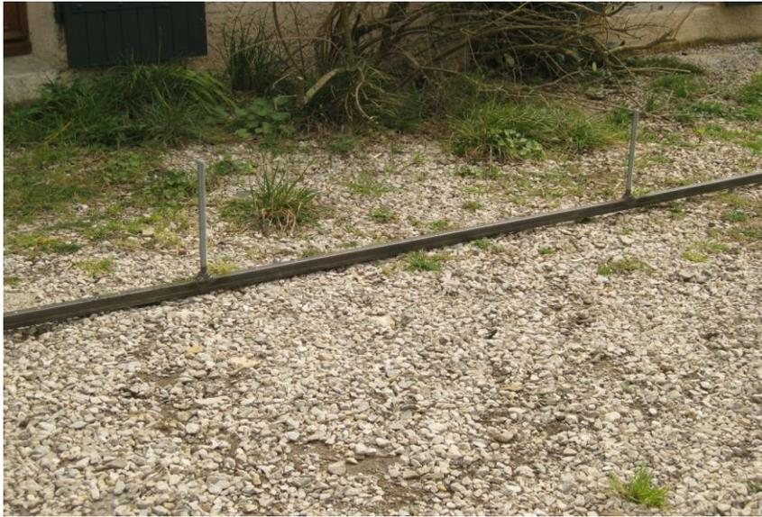
L'ensemble de la structure repose sur 4 tiges filetées, diamètre 14, elles même soudées sur deux tubes rectangulaires de 20X30, de 2.50 m de long (photo ci-contre), qui sont chacun vissés dans la volige de la toiture par une vingtaine de vis (photo suivante).
