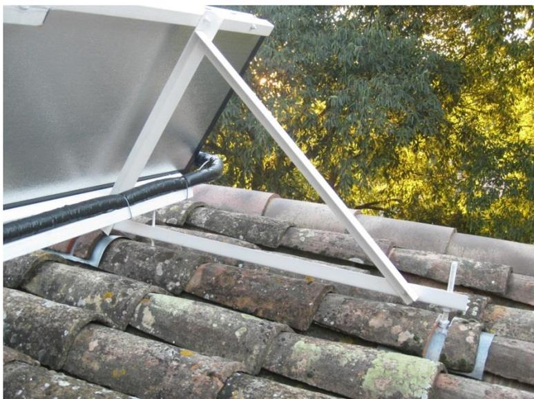
Les capteurs sont montés sur une structure en acier réalisée en partie avec de la cornière profilée à froid de 40, épaisseur 2 mm, pour faire les « triangles » donnant la bonne inclinaison aux capteurs.
