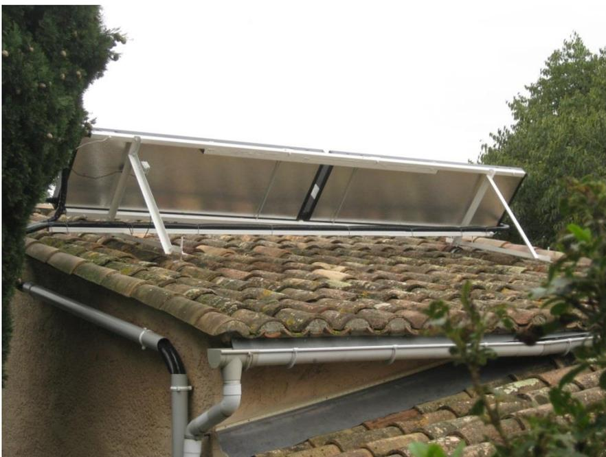
Les capteurs sont fixés grâce à des « clamps » en aluminium fournis avec, sur deux tubes carrés en acier, horizontaux, de 40, épaisseur 2. Avec une portée de 3.50 m, la flèche était trop importante, donc j'ai doublé sur environ 2 m ces tubes, en soudant dessous un autre bout de tube carré, ce qui fait, en quelque sorte, un tube de 80X40. Là, la flèche est négligeable, c'est bon.
