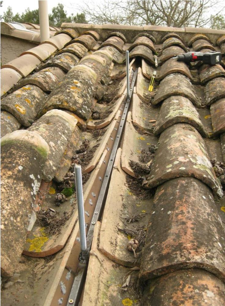
A chaque passage d'une tige filetée, la tuile a été remplacée par une forme de tuile en zinc, avec un écrou de chaque côté, et un joint assurant l'étanchéité à la pluie.
