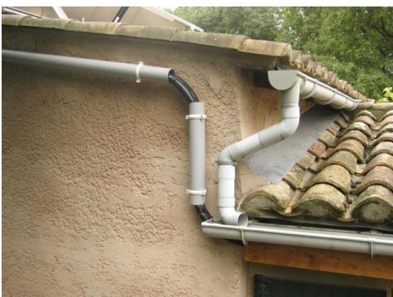
Le circuit solaire chemine en façade dans des tubes PVC diamètre 100
